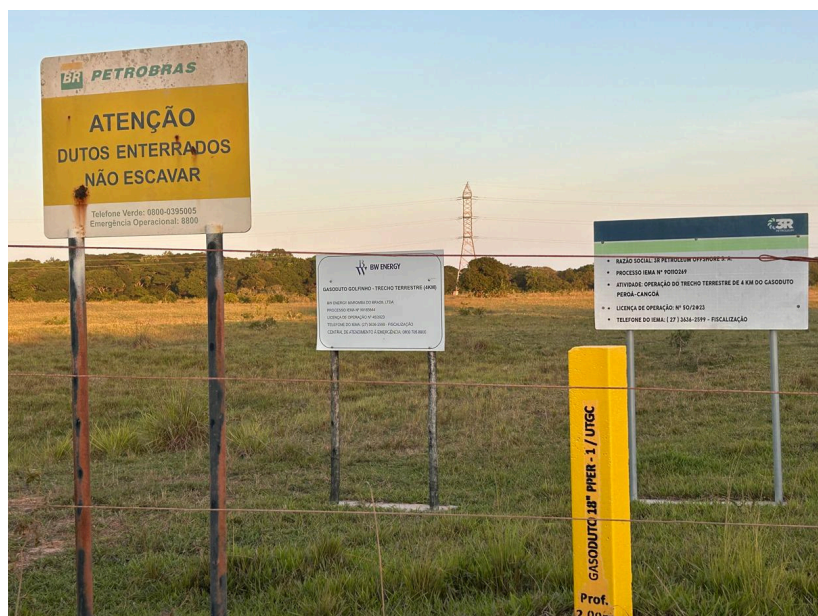
Figura 3: Faixa de servidão do Gasoduto Golfinho, compartilhada com os gasodutos Camarupim (Petrobras) e Peroá-Cangoá (Brava Energia). Fonte: BW Energy.
